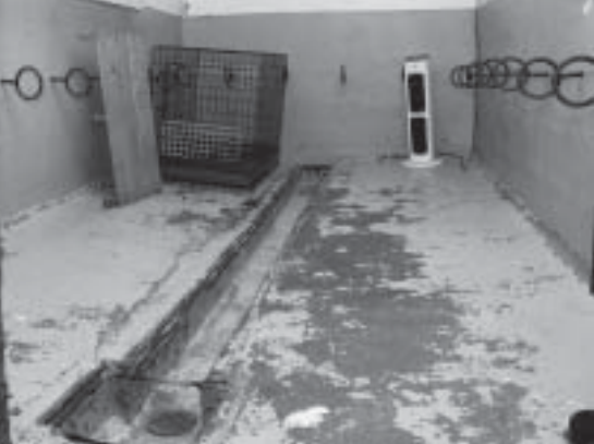
▲犬の収容場。コンクリート製の室内には鉄製の輪が並び、ここに犬を繋留する。殺処分もここで行われている。
